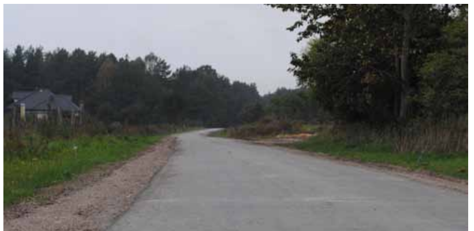
Ta droga łączy Strzelino z Bruskowem Wielkim. Została położona nawierzchnia betonowa (450m) oraz kruszywo (1850m).
