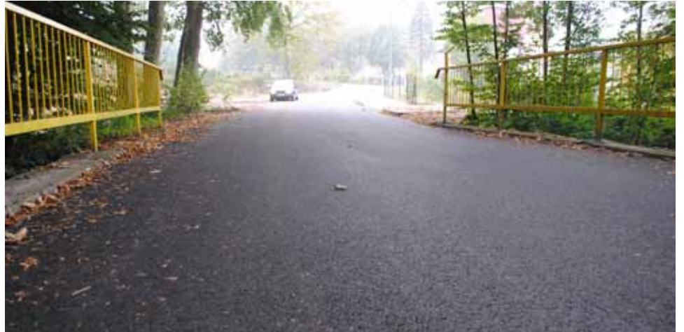
Aleja nad Rzeką we Włynkówku skończona. W tym miejscu planowana jest również kładka dla pieszych.
