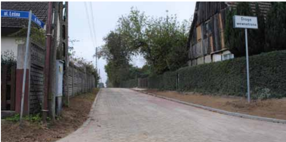
Ulica Krótka w Bierkowie ma już nowy ciąg pieszo – jezdny. Położone zostało 350 m kostki betonowej i płyt MEBA.
