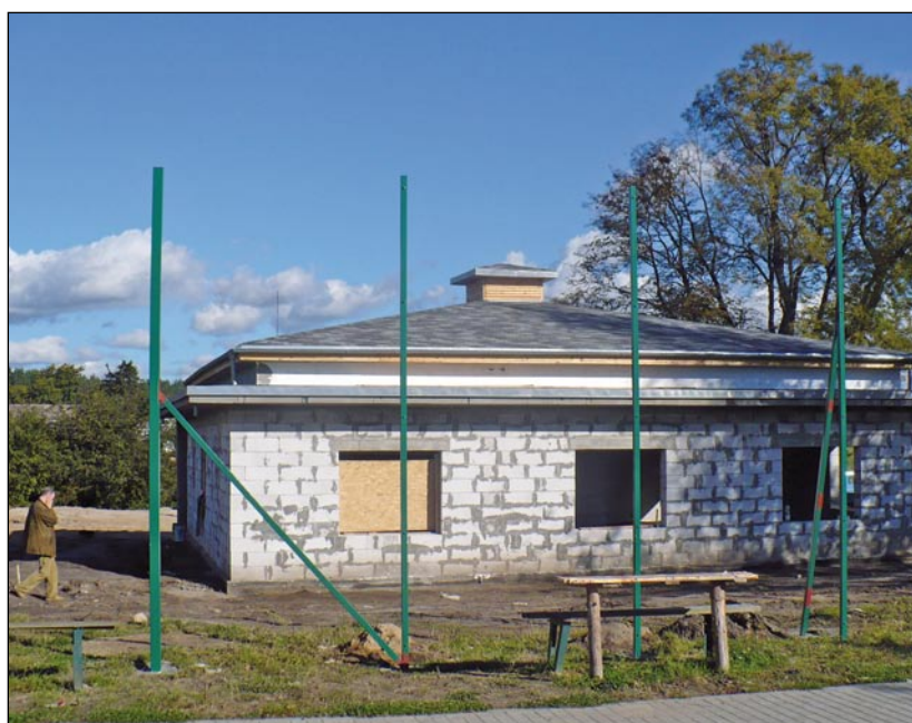
Budowa świetlicy w Warblewie.
